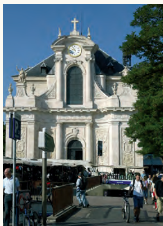
Façade de l'église Saint-Sébastien / © cliché Ville de Nancy
