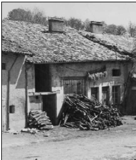
Façade de maison lorraine (photographie ancienne)
