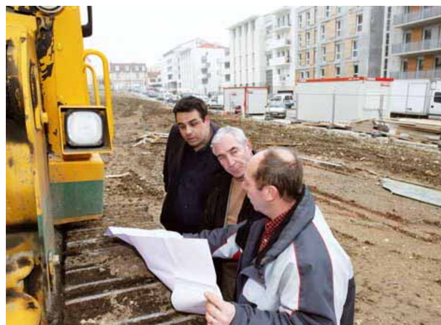
Patrick Baudot et Patrick Blanchot, les élus en charge du dossier, font le point sur le démarrage des travaux.
